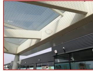
Sistema di dissuasione con reti anti-intrusione
